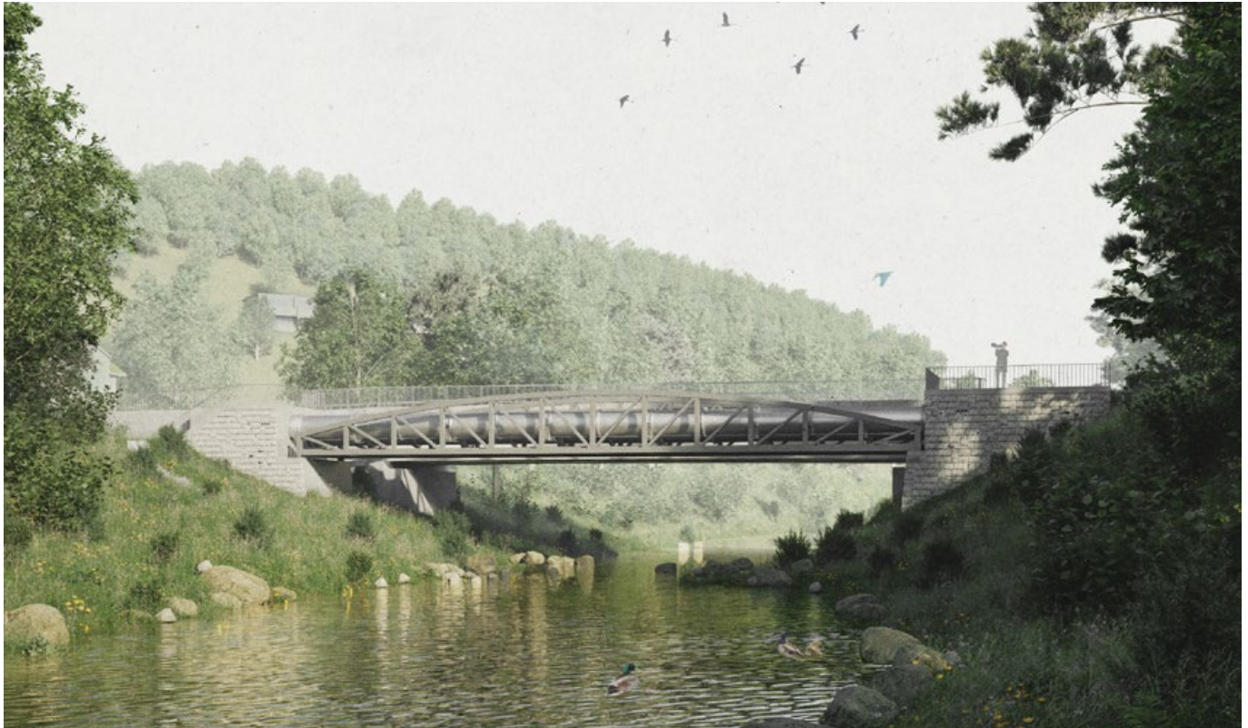
Die neue Rohrbrücke wird parallel zur bestehenden Verkehrsbrücke geführt (Visualisierung: Cristina Rutz Architekten, Winterthur).
