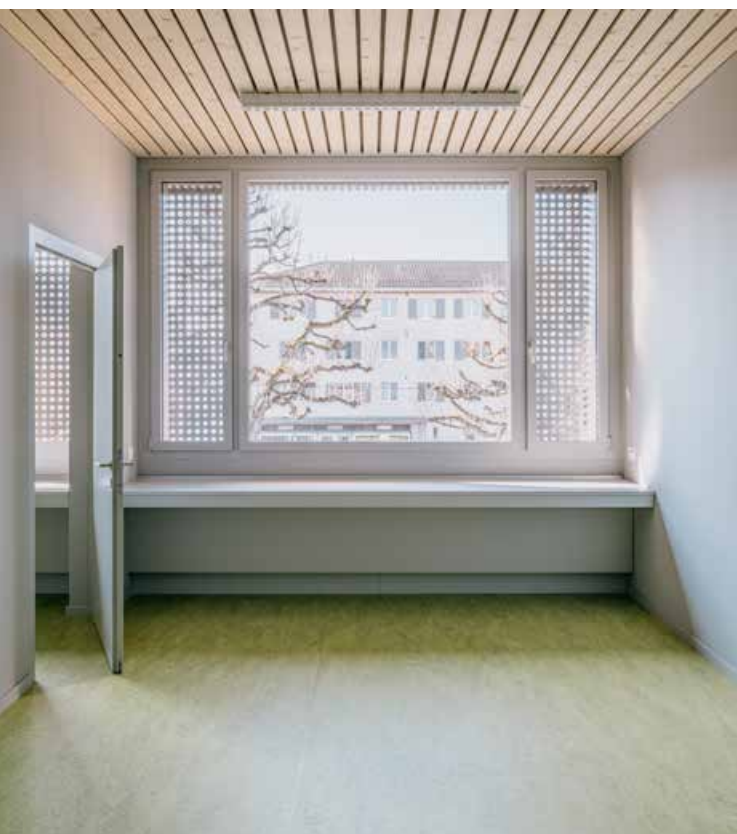
Fenster mit Lüftungsflügeln im Modulbau Schulhaus Wülflingerstrasse
