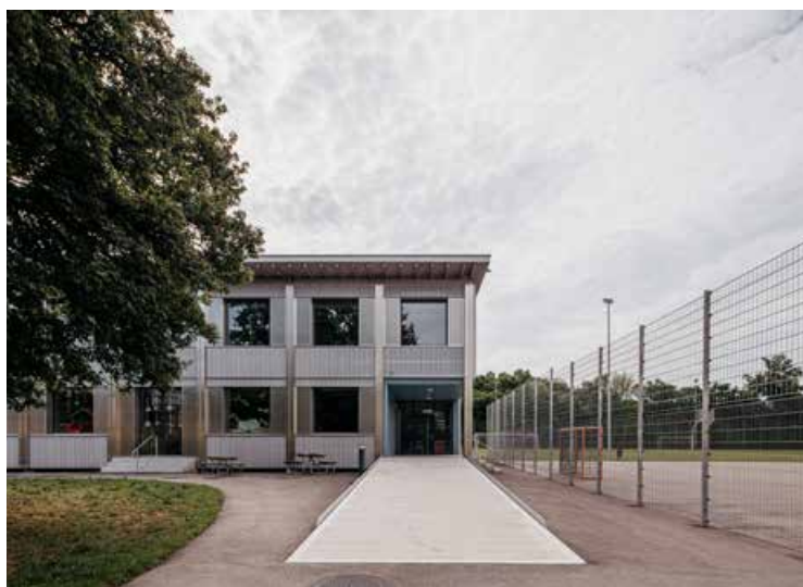
Hindernisfreier Zugang zum Modulbau Schulhaus Langwiesen
