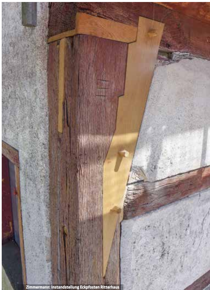
Zimmermann: Instandstellung Eckpfosten Ritterhaus
