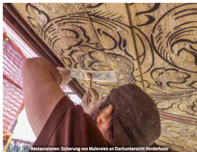
Restauratoren: Sicherung von Malereien an Dachuntersicht Vorderhaus
