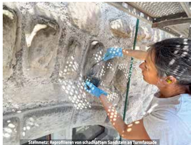
Steinmetz: Reprofilieren von schadhaftem Sandstein an Turmfassade
