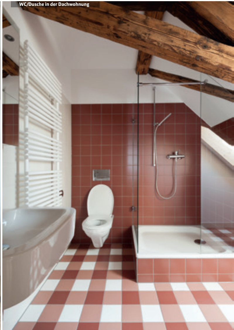
WC/Dusche in der Dachwohnung
