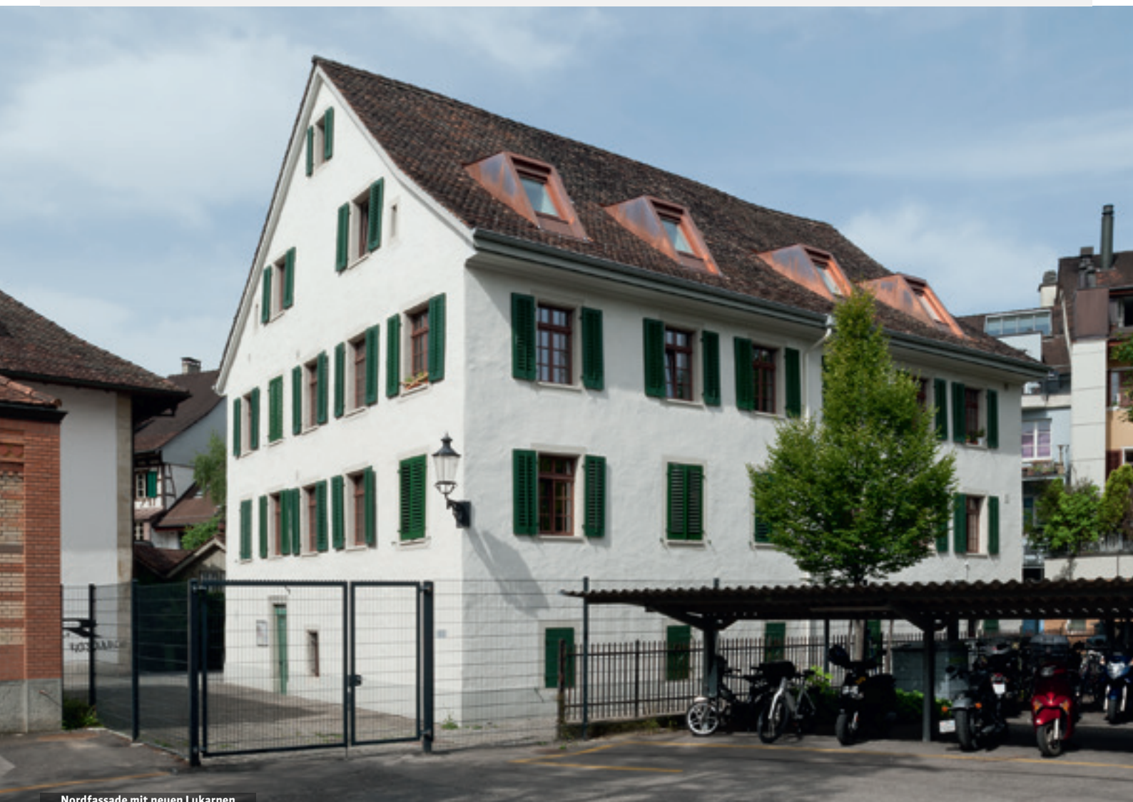
Nordfassade mit neuen Lukarnen
