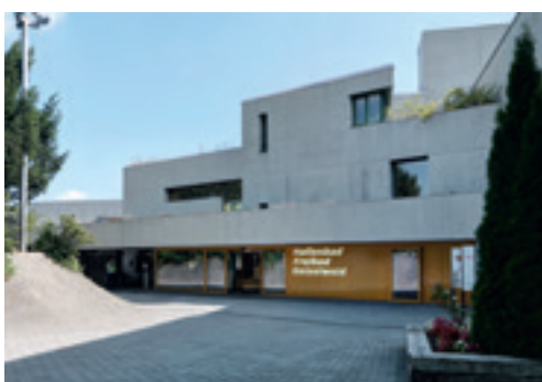
Eingang an der Nordwestfassade
