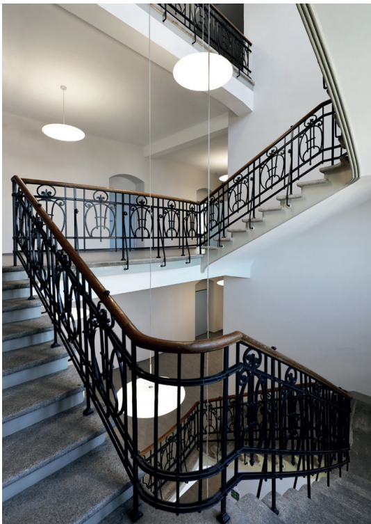
Sanierung Oberstufenschulhaus, Rheineck
