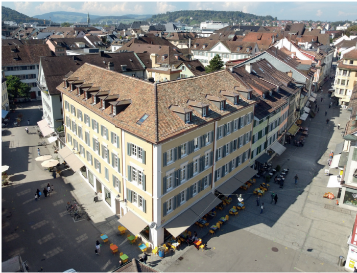
Sanierung Wohn- und Geschäftshaus Bühlfhof, Winterthur
