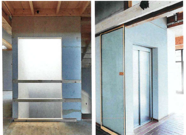
REF: nachträglich eingebauter Lift mit Fertigelementschacht
