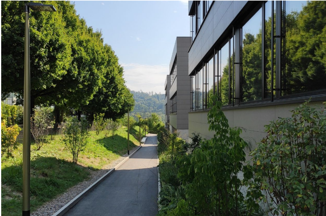
Nordfassade mit den ergänzten Anbauten und Fussverbindung
