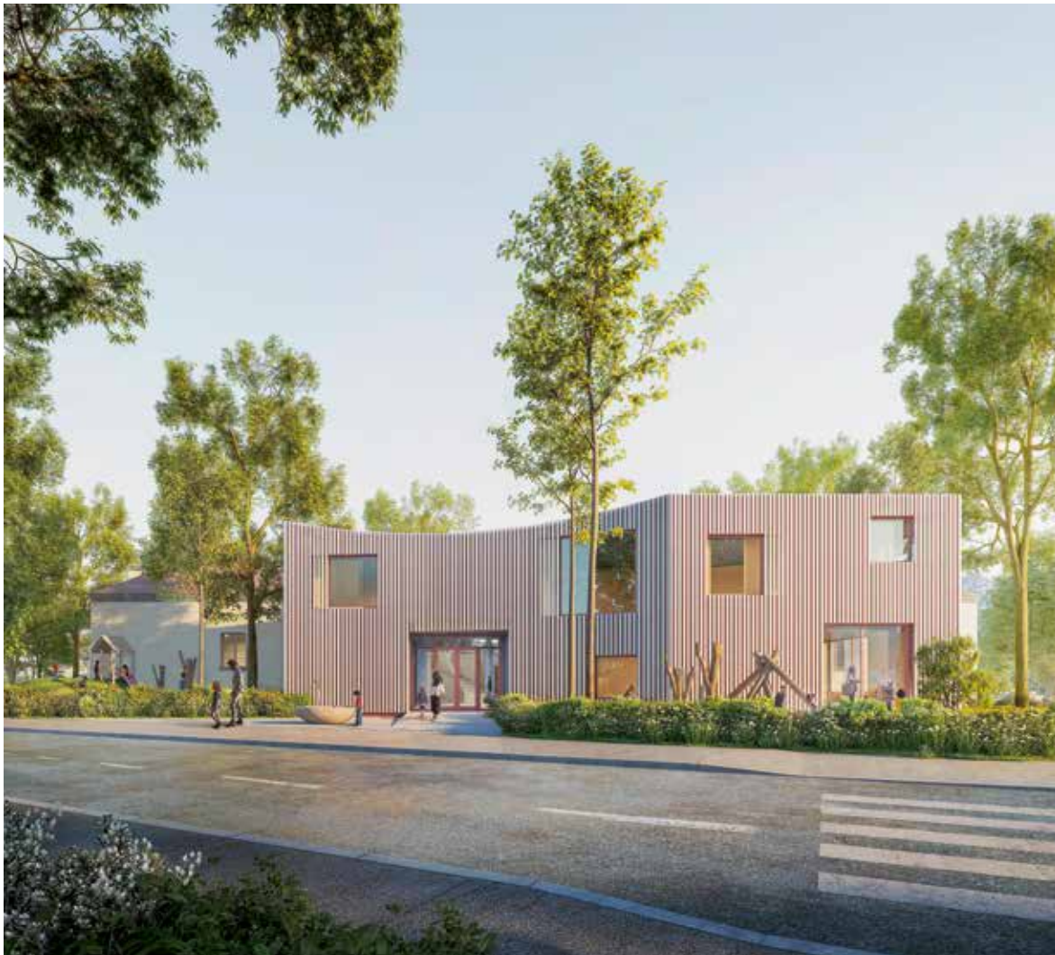
Der Erweiterungsneubau verleiht der Schulanlage ein neues Gesicht an der Ecke Wieshof-/Wolfbühlstrasse
