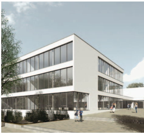
Zugang Dreifachsporthalle von Süden
