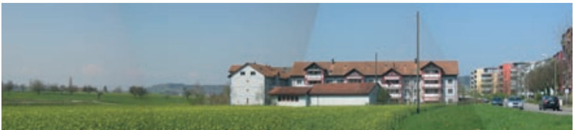
Blick Wettbewerbsareal Richtung Norden mit Schützenhaus im Vordergrund
