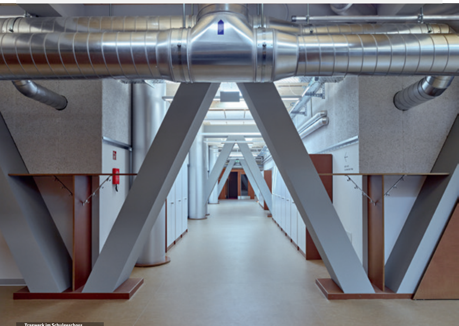
Tragwerk im Schulgeschoss
