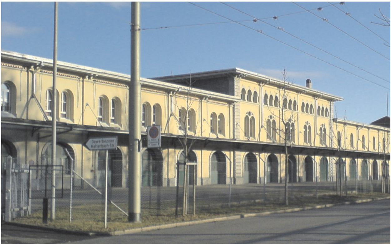
Abb. 1: Westfassade Zeughaus 1, Zeughausstrasse 52
