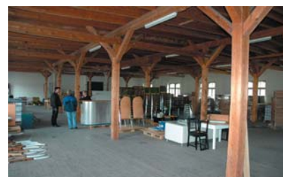
Abb. 5: Unausgebautes OG, Zeughaus 3
