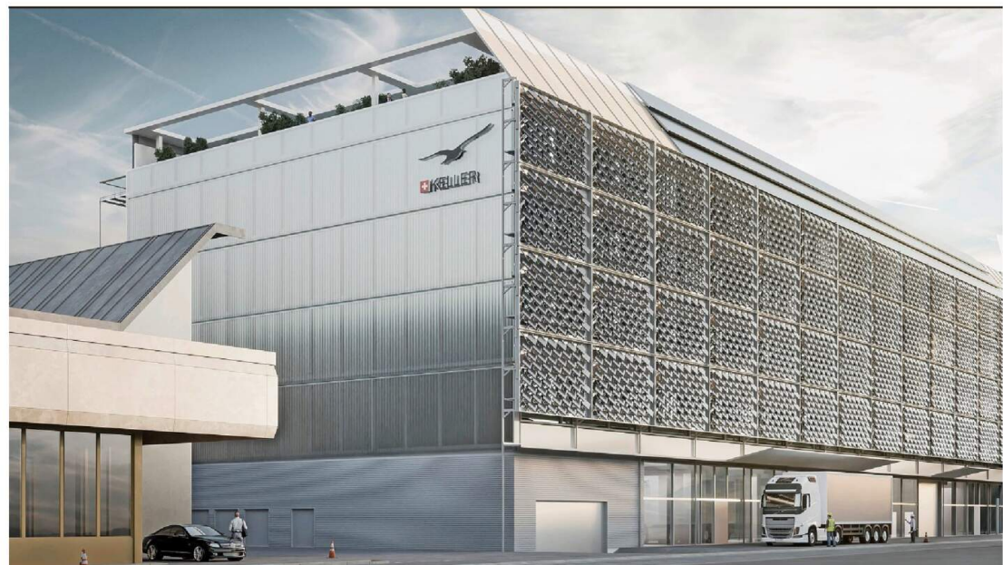
Lieferrn künftig 65 Prozent der Energie für die Produktion: Die schwenkbaren Fotovoltaik-Panels an der Fassade des neuen Produktionsgebäudes. Visualisierung: Strut Architekten
