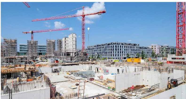
Beton, Glas und Holz: Blick auf die Baustelle von «Kim». Links im Bild der frühere Europazust von DMG Mori, daneben die Holzhauserei Sue & Til (hellblau) und Giesserei (rot). Foto: Enzo Lopardo
