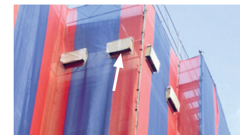
Alpenseglernistkästen an einem Baugerüst.
