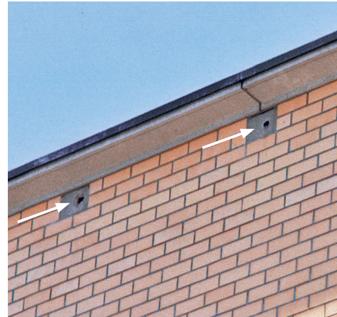
In die Fassade eingelassene Niststeine.
