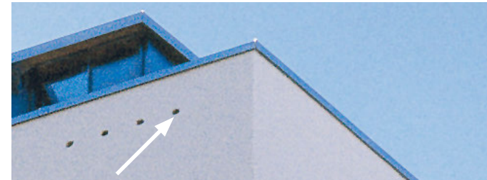
Fertiggestellter Neubau mit eingebauten Seglernistplätzen.
