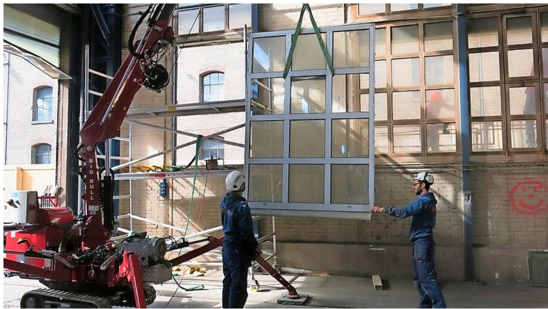
Fenster aus anderen alten Gebäuden werden demontiert und nebenan zwischengelagert.
