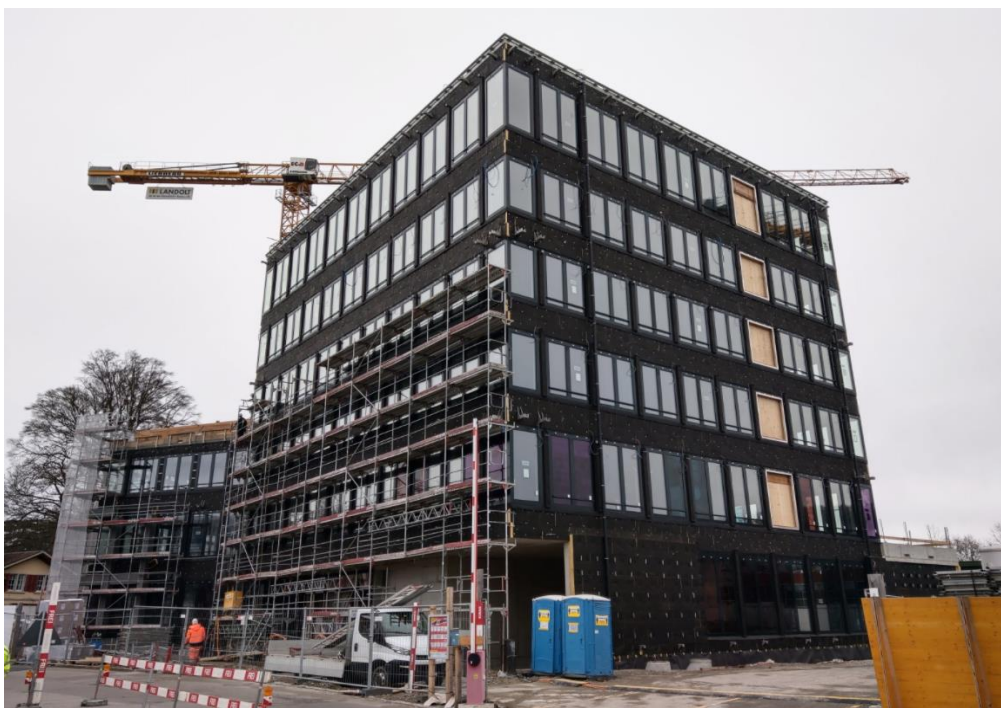
Das POM im Bau
