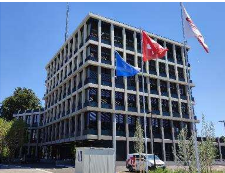
Polizeigebäude an der Obermühlestrasse
