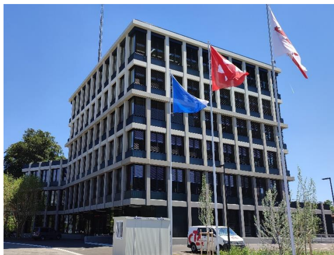
Polizeigebäude an der Obermühlestrasse
