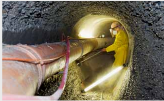
↑ Kostenintensive Innen-sanierung von Kanälen
