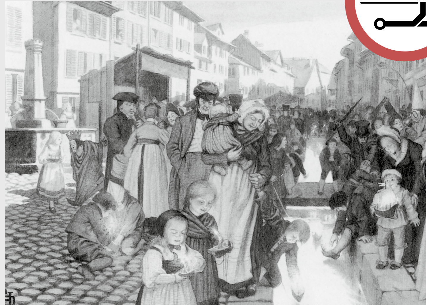
⤴ Bis 1835 floss der Stadtbach offen durch die Gassen der Winterthurer Altstadt. Hier ein Bild aus der Steinberggasse. Abfälle hineinzuwerfen war verboten, ausser am Samstag: Da wurde der Stadtbach durch- und der Abfall weggespült.
