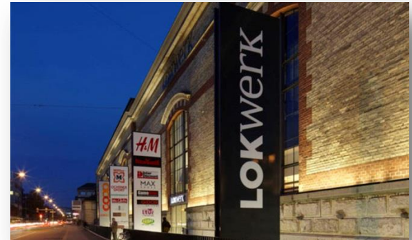
Einkaufszentrum Lokwerk, Zürcherstrasse 51 Baujahr 2009, 9'000 m2 vermietbare Fläche
