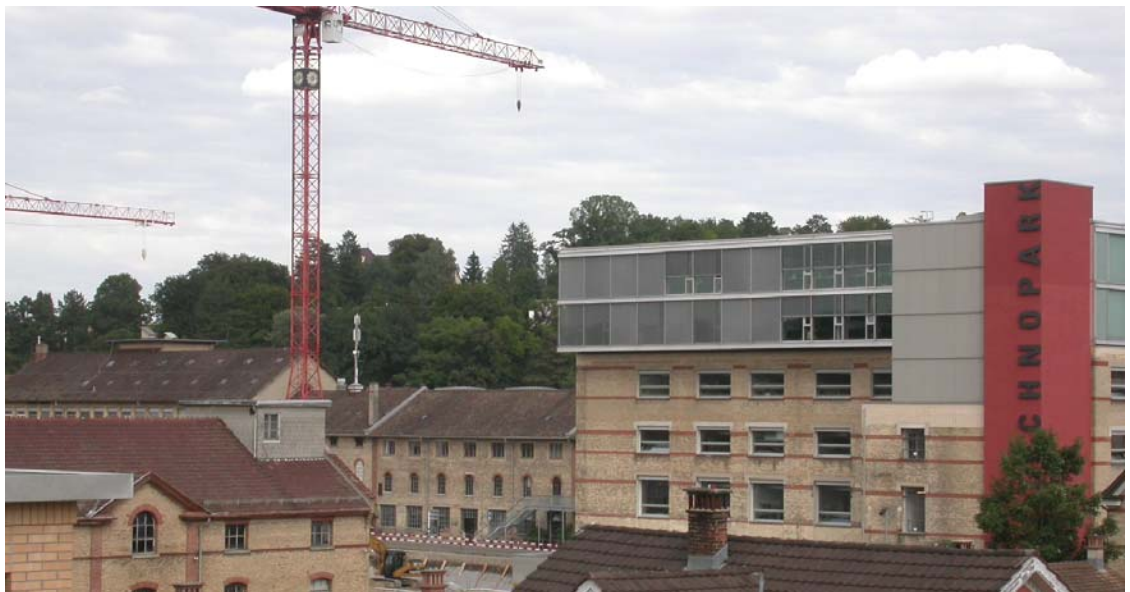
Technopark Winterthur mit Baustelle für Erweiterung (Foto Stadtentwicklung)
