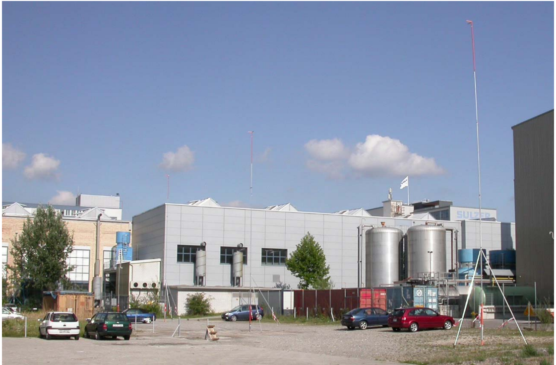
Ausbauprojekt Werkhalle Burckhardt Compression auf Restareal in Oberwinterthur (Foto Stadtentwicklung)
