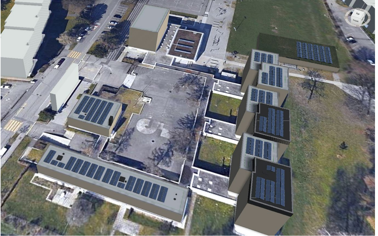
Ansicht Schulareal Tägemoos mit Fotovoltaik-Modulen
