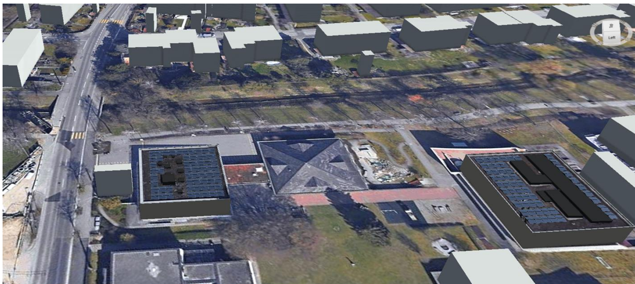
Ansicht CPS Maurerschule mit Fotovoltaik-Modulen
