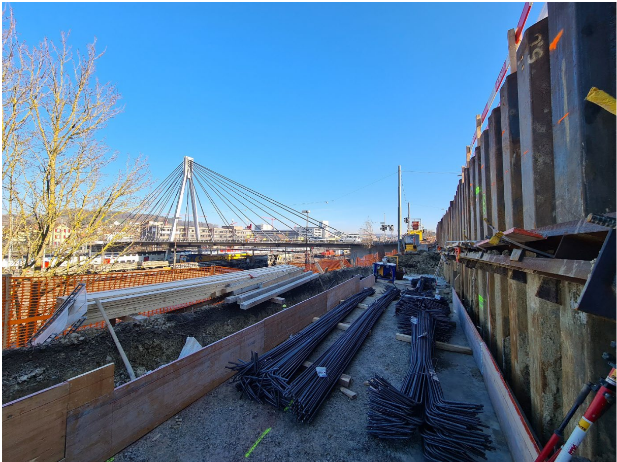
Legende: Strassenbaustelle untere Vogelsangstrasse
