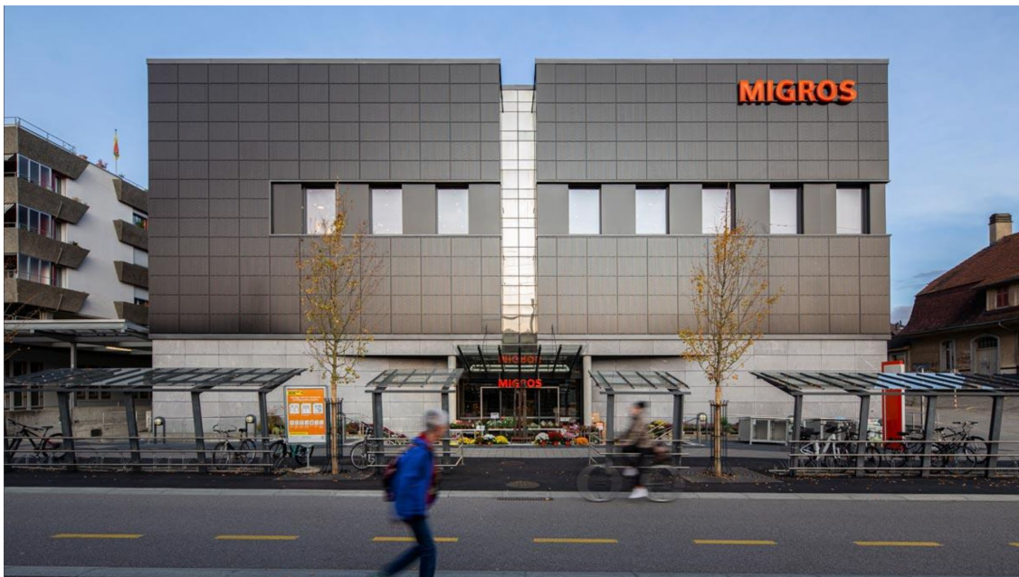
Abbildung 5 In der Migros-Filiale Münsingen hat die Genossenschaft Migros Aare im Jahr 2020 erstmals eine Solarfassade in Betrieb genommen. Die Fassade hat eine Fläche von 1'816 m 2 , wovon 1'233 m 2 mit Solarmodulen mit einer Gesamtleistung von 218.5 kWp belegt sind. ( Link , © Migros)
