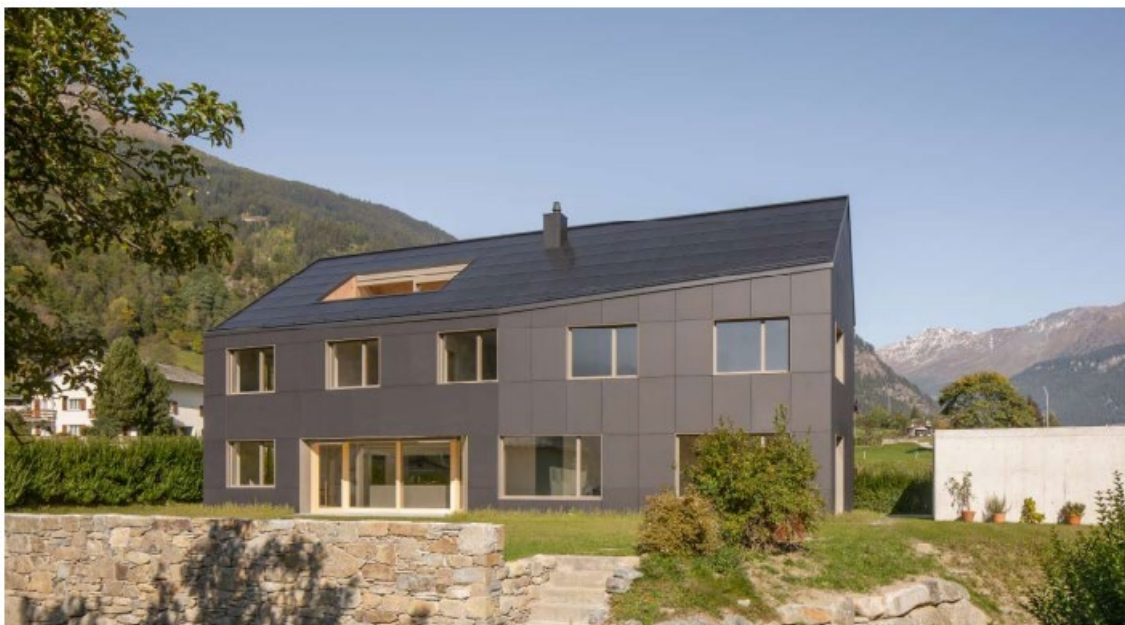
Abbildung 6: Das MFH in Poschiavo generiert dank der ganzflächigen fassaden- und dachintegrierten PV-Anlage rund 45'000 kWh pro Jahr. Dies führt zu einem Solarstromüberschuss von rund 509% oder 37'600 kWh/a. Das Haus erhielt den Norman Foster PEB-Solar Award 2022 sowie den Schweizer Solarpreis 2022 dafür. Neben der erstaunlichen Stromproduktion über das ganze Jahr, besticht das Gebäude durch eine attraktive Architektur und moderne Ästhetik. ( G-22-10-01 Solarpreispublikation 2022 , Foto: Schweizer Solarpreis 2022)
