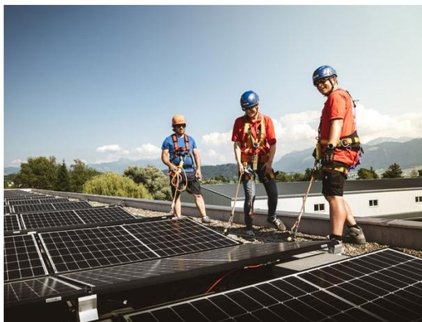
Abb. 1: Absturzsicherung Seilsystem (links) sowie Personen mit Schutzausrüstung, gesichert an einem Seilsystem (rechts)
