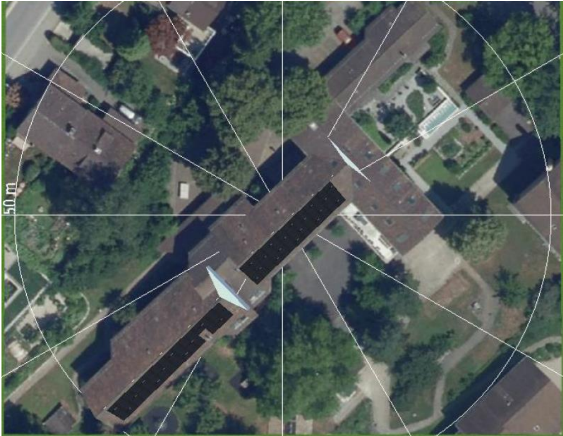
Ansicht Dach mit Fotovoltaik-Modulen Kinder- und Jugendheim Oberi
