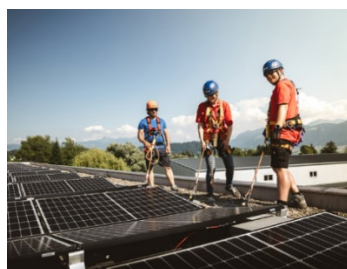
Abb. 2: Personen mit Schutzausrüstung, gesichert an einem Seilsystem
