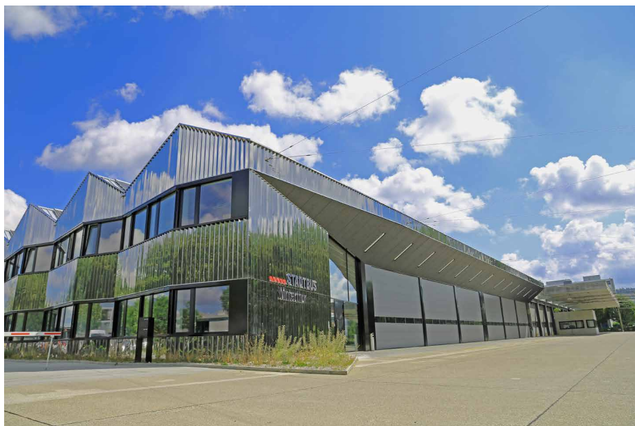
Abb. 32: Neuer Verwaltungstrakt und erweiterte Einstellhalle.
