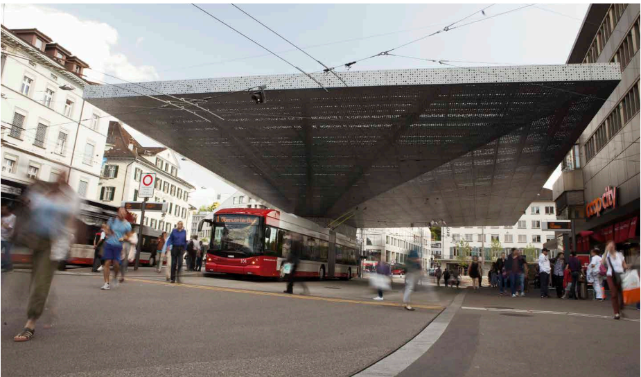
Abb. 31: Der neue Busbahnhof.
