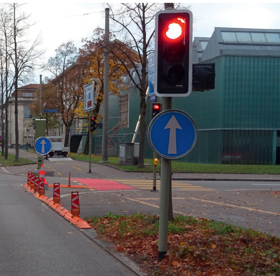
Durch die Einschränkung der Fahrbeziehungen konnte der Verkehrsdurchsatz mit längeren Grünphasen an der Lindstrasse / St.-Georgen-Strasse verbessert werden.
