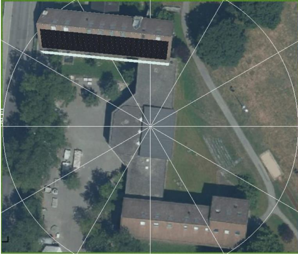
Ansicht Dach mit Fotovoltaik-Modulen Schulhaus Rosenau
