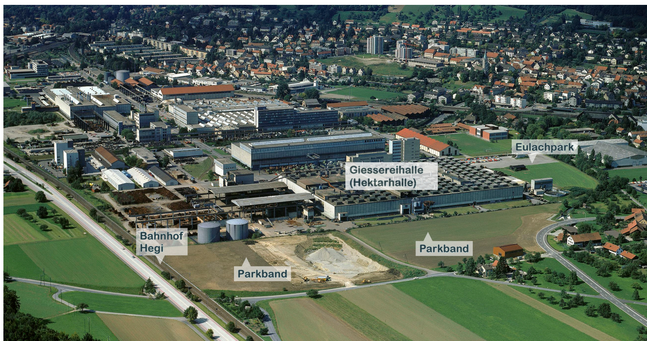
Sulzer Oberwinterthur, Im Vordergrund die Giessereihalle (Hektarhalle) Luftaufnahme 1976, ETH-Bibliothek Zürich, Bildarchiv / Fotograf: Krebs, Hans / Com_FC24-8400-0070 Auf Bild markiert: heutige Lage Parkband, Eulachpark und Bahnhof Hegi
