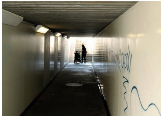
Nördl. Bahnunterführung Oberwinterthur
