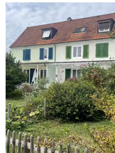
Bauzeitliche Pergola - Haustyp C
