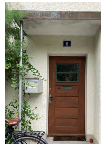
Hauseingang, bauzeitlicher Zustand
