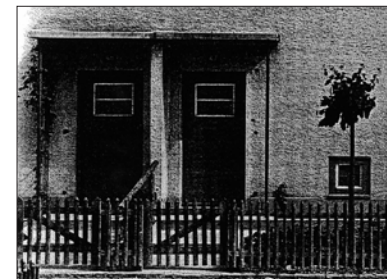
Hauseingang Eigenheimweg, bauzeitlicher Zustand
