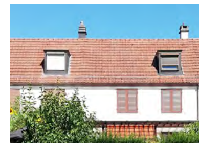
Dachfläche Haustyp C
