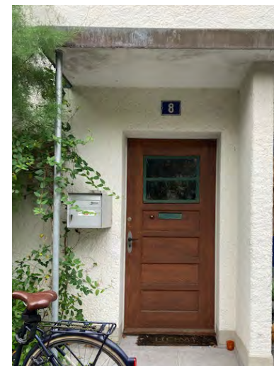
Hauseingang, bauzeitlicher Zustand
