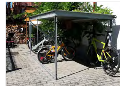
Fahrradunterstand bestehend, Material und Masse i.O.
