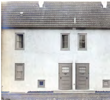
Historische Aufnahme der Strassenfassade
