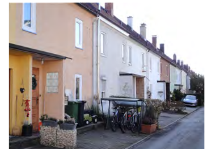
Eigenheimweg mit Blick auf die Fassaden
