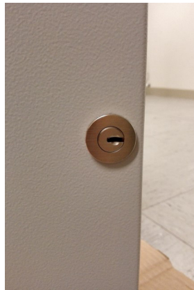
Zylinder muss, 90° verdreht eingebaut werden! (Rahmen)
