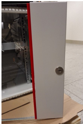
KABA-Zylinder einbauen
