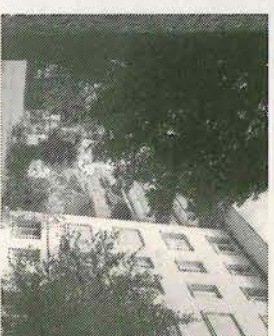
Links: Villa «Malabar» an der Lindstrasse 1868 von Georg Schultheß erbaut; 1955 abgebrochen zugunsten einer Blocksiedlung (oben).
