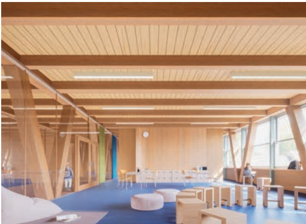
Klassenzimmer: Das Raumfachwerk erlaubt flexible Grundrisse
