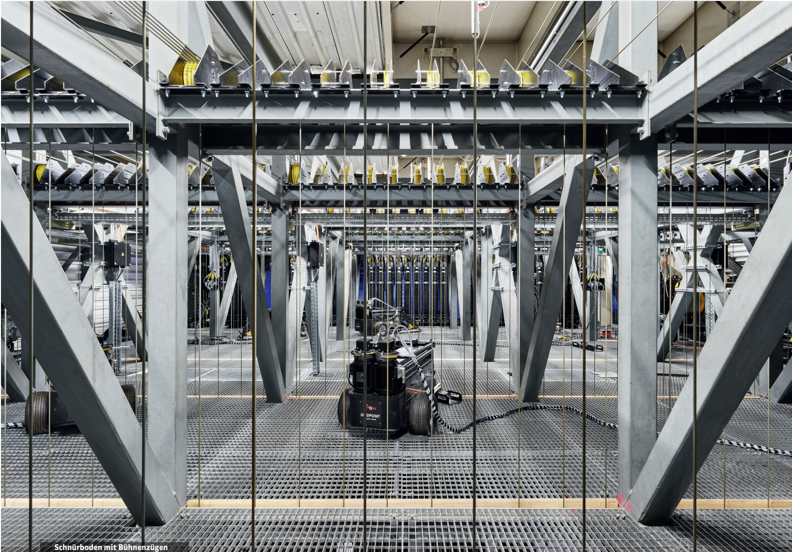
Schnürboden mit Bühnenzügen
