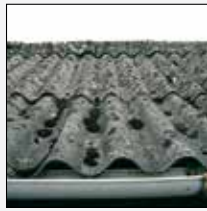
Welleternit und Wärmebitumenplatten
