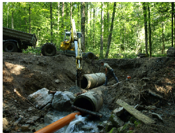
Reparatur am Mittleren Krebsbachweg im Seemer Tobel
