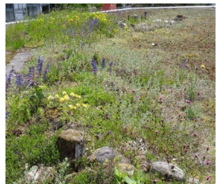
Abb. 2: Artenreiche extensive Dachbegrünung, angereichert mit Strukturelementen und Substratmodellierung
