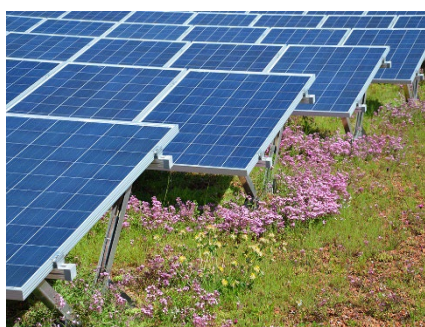
Abb. 3: Dachbegrünung und Photovoltaik
