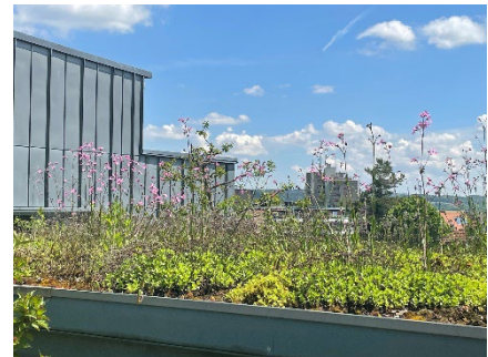
Abb. 1: Extensive Dachbegrünung
