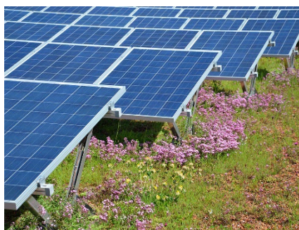
Abb. 3: Dachbegrünung und Photovoltaik
