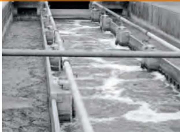
Sand- und Fettfang. Die Fließgeschwindigkeit des Abwassers wird verringert und Luft eingeblasen. So setzen sich Sand und kleine Partikel ab und können entfernt werden. Das Fett schwimmt in den beruhigten Zonen auf und kann abgezogen und der Verbrennung zugeführt werden. Ein energieaufwendiger Prozess. Die Kapazität reicht nur für das nicht vermeidbare Speisefett im Abwasser.
