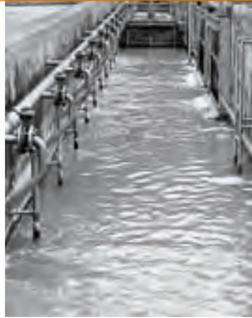
Verteilrinne. Durch ein Rinnensystem wird das vorbehandelte Abwasser auf die verschiedenen Becken der biologischen Reinigungsstufe verteilt.
