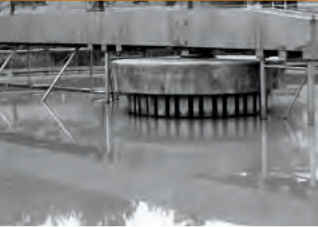
Vorklärung. Letzter Vorbereitungsschritt vor der biologischen Reinigung. Verteilbauwerk in der Mitte und Rümer für den abgesetzten Schlamm. Das Ziel ist es, das Wasser für ein bis zwei Stunden mit einer möglichst gleichmässigen, aber niederen Strömung durch das Becken zu führen, damit sich der Schlamm vom Wasser trennen kann.
