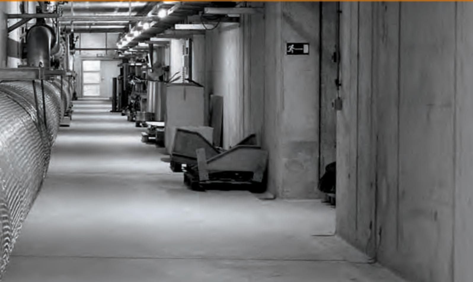
Der rund 700 Meter lange Energiekanal ist ein unterirdischer Tunnel, in dem sämtliche Versorgungs- und Energieleitungen installiert sind. Prominent im Bild zu sehen ist die Luftversorgungsleitung für die biologische Reinigungsstufe. Hier wird auch bildlich fassbar, warum rund 60 Prozent des Stromverbrauches der ARA für die Luftversorgung der biologischen Reinigung benötigt werden.
