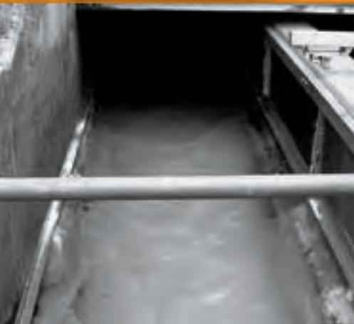
Einlaufkanal für das Abwasser. Mit Rechen für die Hochwasserentlastung. Durchschnittlich gelangen hier 600 bis 800 Liter Abwasser pro Sekunde in die ARA. Mengen über 2000 Liter fließen durch den Rechen in die Regenauffangbecken und von dort teilweise in die Töss.
