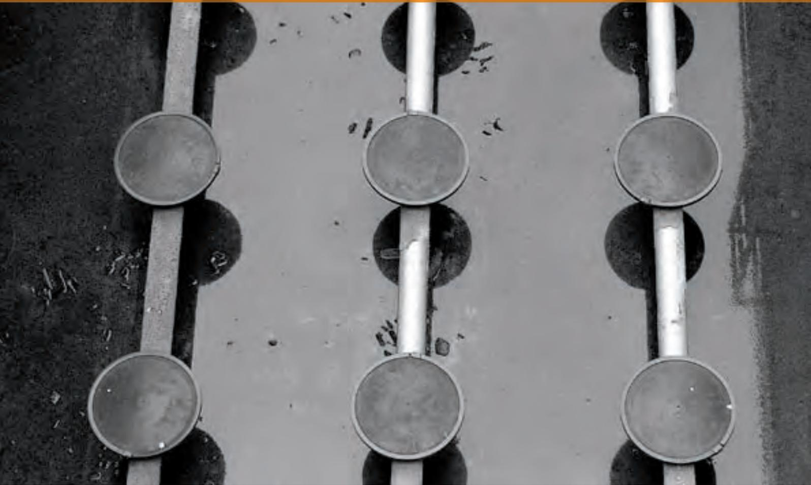
Biologische Reinigung. Der Blick in ein entleertes Reinigungsbecken. Zu sehen sind die tellerförmigen Belüftungsdomen. Sie versorgen die Mikroorganismen mit dem nötigen Sauerstoff und erlauben eine relativ feine Dosierung und Durchmischung des Wassers. Solche Belüftungsdomen gibt es in der ARA Tausende. Doch niemand arbeitet umsonst. Auch keine Mikroorganismen. Der Lohn für ihre Arbeit ist Luft. Eben diese Luftversorgung verschlingt in der ARA rund 60 Prozent des Stroms.
