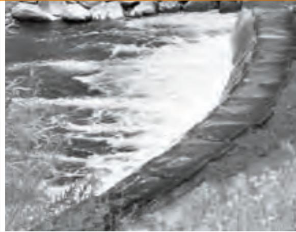
Einleitung in die Töss. Das gereinigte Abwasser wird der Töss über einen speziellen Einleitungsbau zugeführt. Dieser trägt dazu bei, dass sich das gereinigte Abwasser optimal mit dem Tösswasser durchmischt und der natürliche Gang der Töss so weit als möglich ungestört bleibt.
