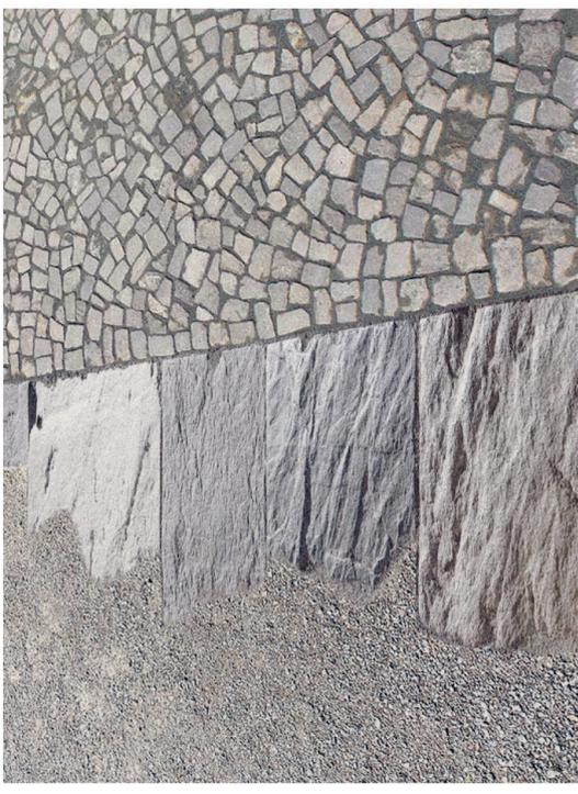
Visualisierung der Schwellenmomente im Bodenbelag (v.l.n.r.: Chausseierung, Steinplatten, Pflastersteine in Pflasterverband)
