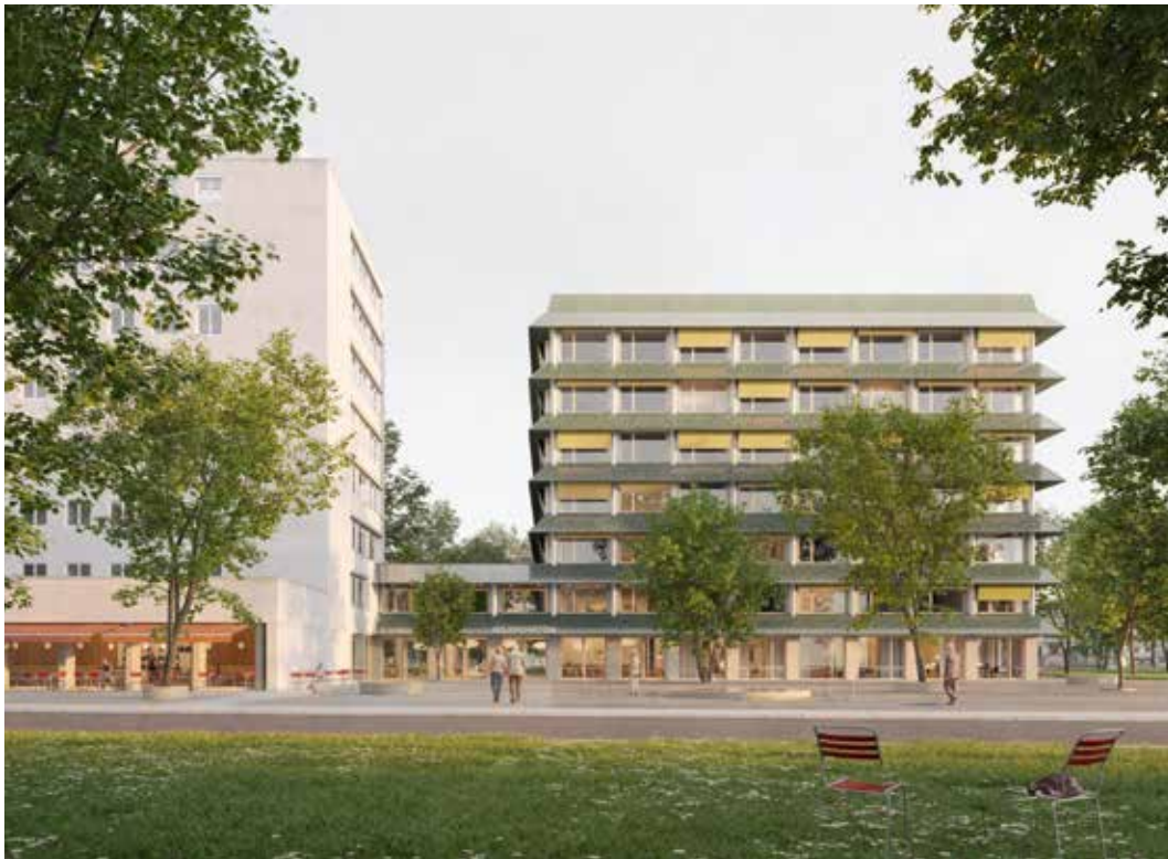
Ein befestigter Vorplatz formuliert die Adressbildung des Alterszentrums mit.
