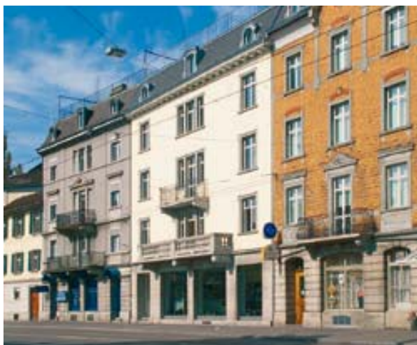
Altstadthaus Technikumstrasse 98, saniert im Minergie-Standard | Bild: Amt für Städtebau Winterthur
