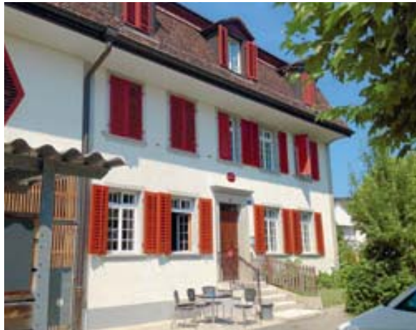
«Zum Neuen Haus», nach den Renovationsarbeiten | Bild: Denkmalpflege Winterthur
