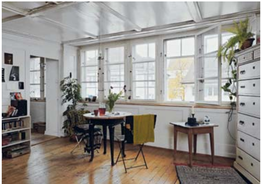
Historische Fenster boten oft differenzierte Lüftungsmöglichkeiten, beispielsweise mit einem kleineren oberen Kippflügel oder Winter- und Sommerfenster. | Bild: Christian Schwager
