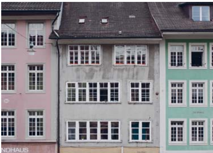
Weil die Herstellung grosser Glasscheiben früher zu kostspielig war, wurden kleine Gläser mittels Holzsprossen zu Fensterflügeln verbunden. | Bild: Christian Schwager
