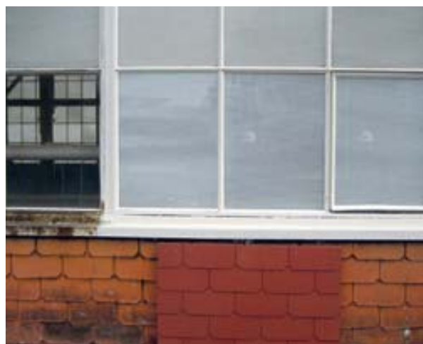
City Halle, Fassadendetail | Bild: Amt für Städtebau
