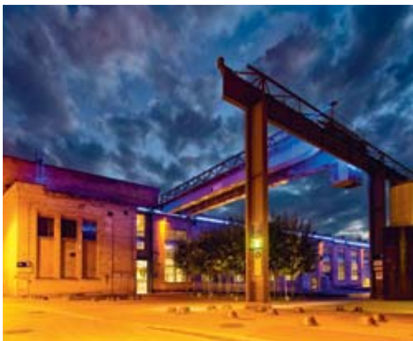
Halle 53, Aussenansicht | Bild: Implenja, Alessandro della Bella
