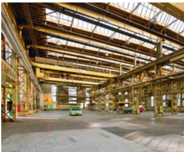
Halle 53, Innenansicht | Bild: Implenja, Alessandro della Bella
