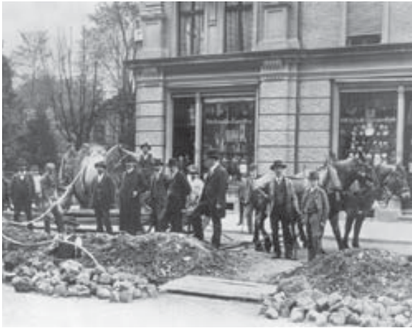
Kabelverlegen, Stadthausstrasse um 1910 | Bild: Winterthurer Bibliotheken, Studienbibliothek
