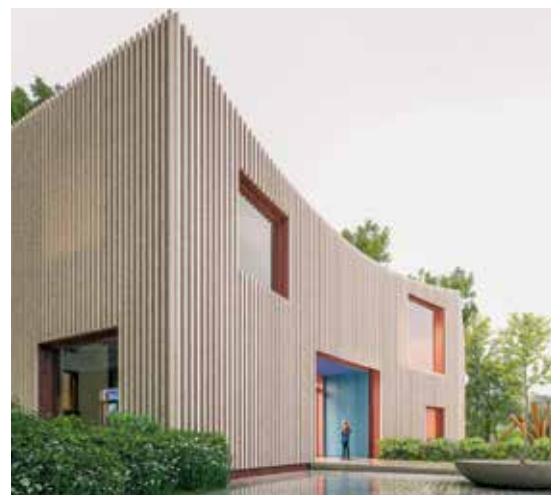
Platz und Fassade zur Wieshofstrasse
