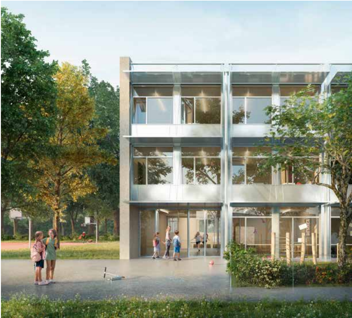
Vorplatz und Eingang des Neubauvolumens
